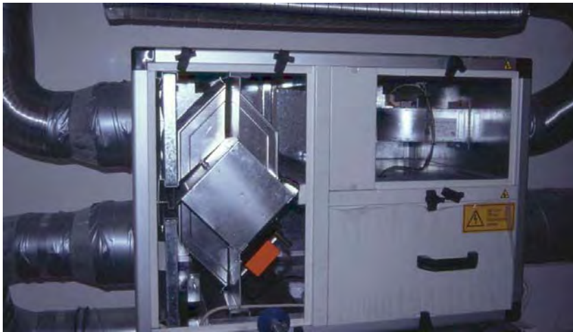
Abb. 1.2.1 Lüftungsgerät zur Abluftwärmerückgewinnung
