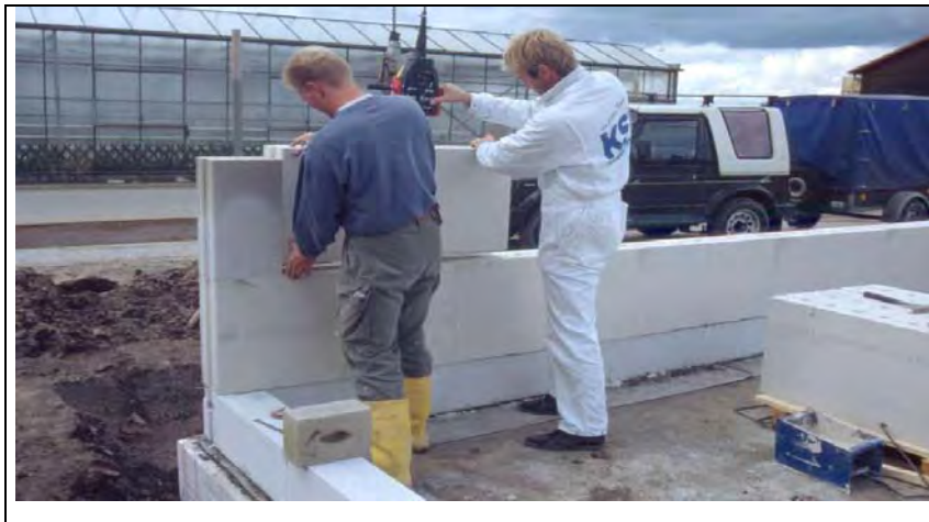
Abb. 2.3.3.1 EG-Mauerwerk mit porosiertem Steinmaterial am Fusspunkt
